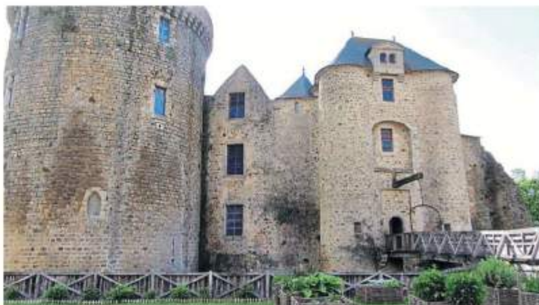
La restauration concerne l'office nord, la partie à droite de l'escalier.
