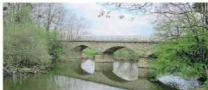
Le pont de Veillerit qui sépare Saint-Mesmin et Montravers (79).
