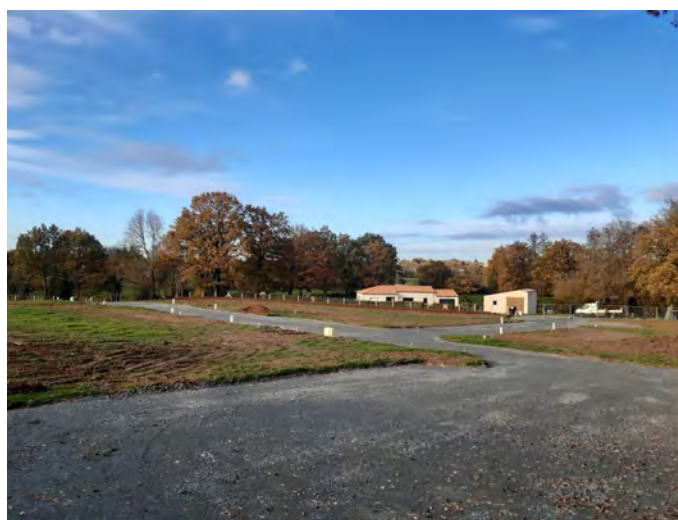
Parking et voirie principale en attente de la 1 ère couche de revêtement.
