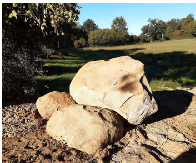
Début d'aménagement d'une aire de jeux naturelle
